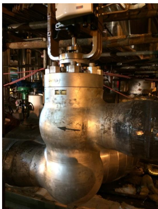
图 38 安装好的锻造蒸汽调节阀（材料 F91）
