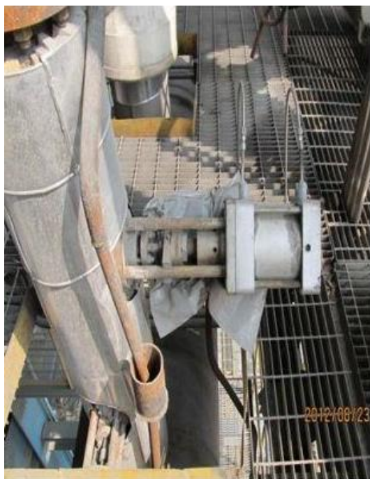
于 2010 年 8 月安装在神华江油发电厂的 PCV 阀
