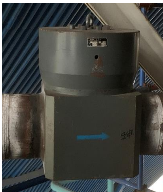
图 44 国华太仓电厂 630MW 超临界机组 主给水止回阀（P=34MPa）
