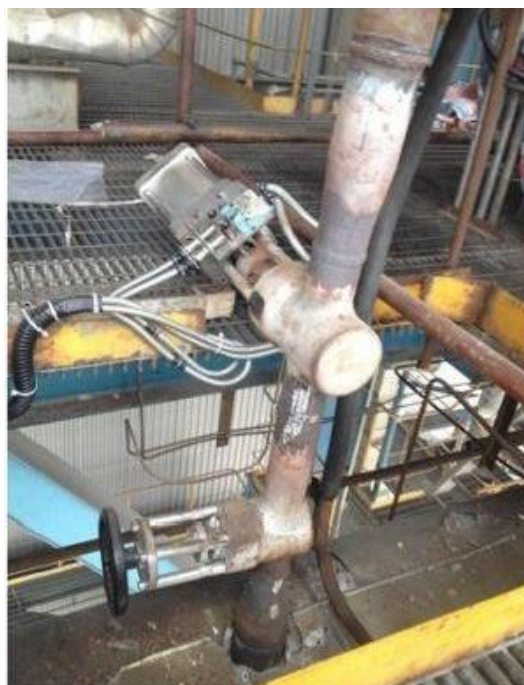
于 2011 年 10 月安装在神华江油发电厂的 PCV 阀
