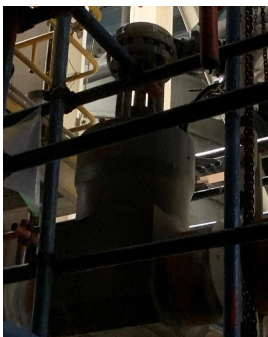
图 43 国华太仓电厂 630MW 超临界机组 主给水闸阀（P=34MPa）
