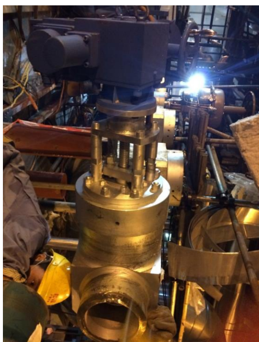
图 37 正在安装的闸阀
