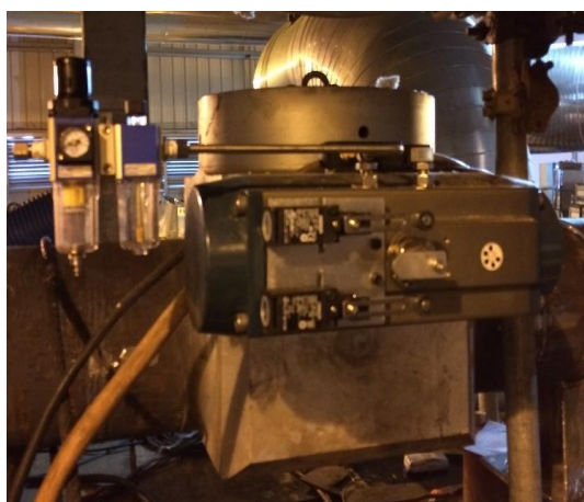
图 35 安装好的抽汽止回阀
