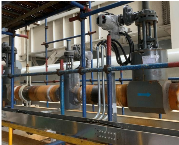
图 42 国华太仓电厂 2*630MW 超临界机组 主给水旁路调节阀和闸阀（P=34MPa）
