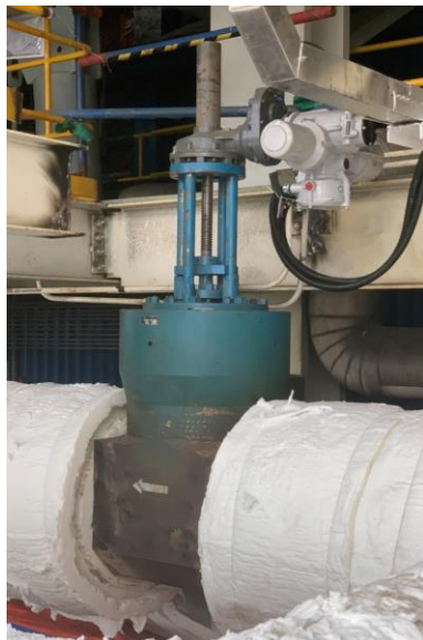
图 41 国华太仓电厂 2*630MW 超临界机组主给水 憋压阀（P=34MPa）
