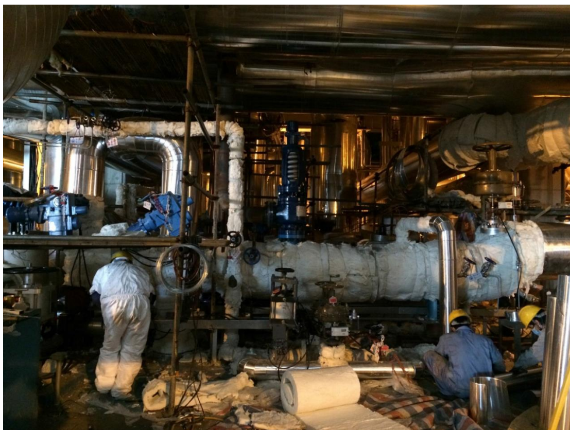
图 39 安装好的减温减压装置。其中，减温水取自主给水，减温水调节阀的压差很大。自 2015 年 3 月开始运行到现在，调节阀运行很好，没有更换零部件。整套系统中的疏放水阀（手动和气动）、电动闸阀、抽汽止回阀都运行良好。注：本系统一年启停 300 次左右。
